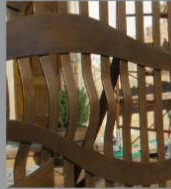
ESEMPIO DI RUGGINE NATURALE CON OXID OIL
